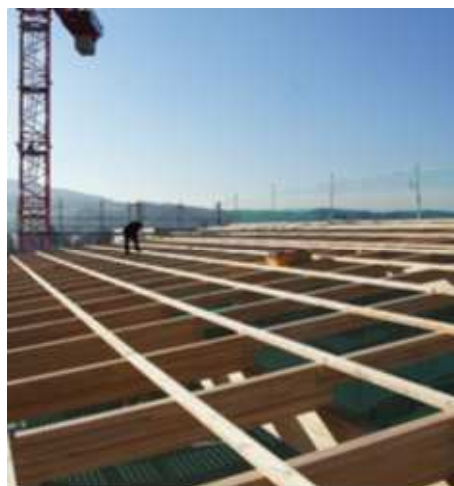
Weitspannende und dennoch filigrane Dachkonstruktion dank Buchen-Brettschichtholz.
