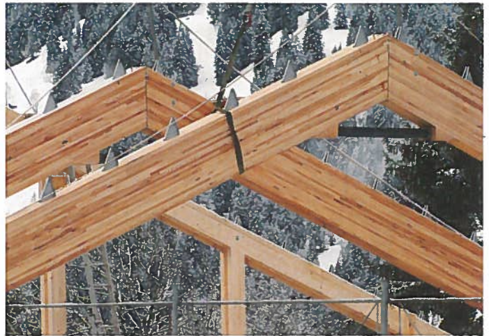
Die besonderen Materialeigenschaften des Buchenholzes ermöglichen eine schlanke Tragkonstruktion.
