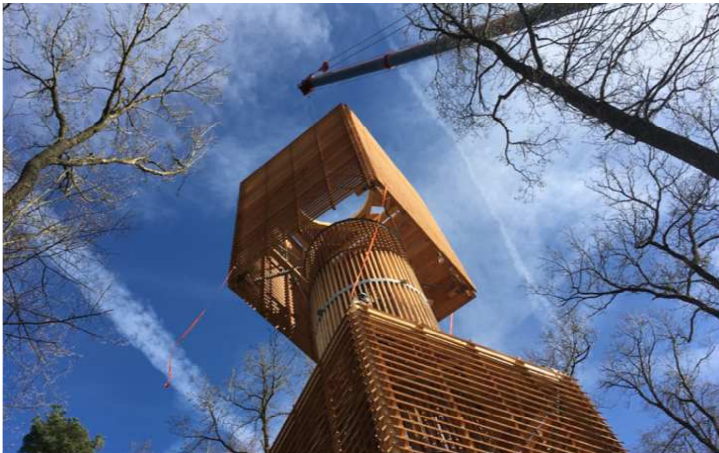
Ein PS starker Pneukran hievt eine Plattform auf den Napoleonturm.
