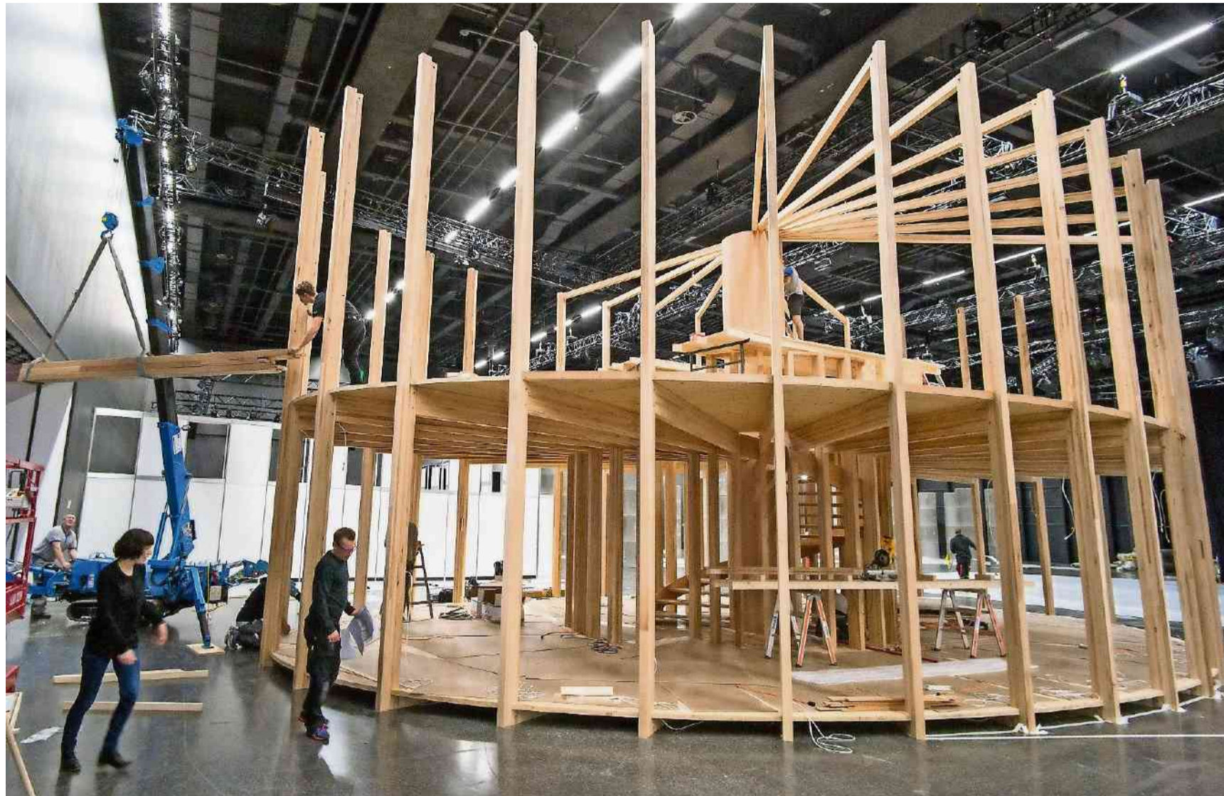
Beim Aufbau in der Basler Messe offenbarten sich die schlanken Trägerelemente, die eine optisch leichte Bauweise ermöglichen.
