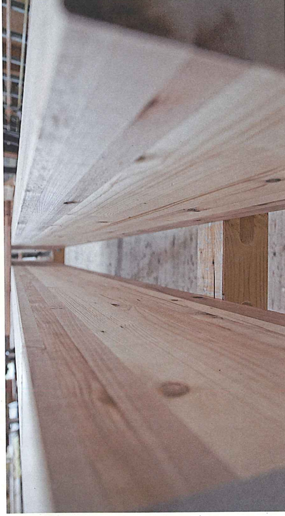
Buche kann Stahl ersetzen: Brettschichtholz für schlanke Konstruktionen im Hochleistungsholzbau
