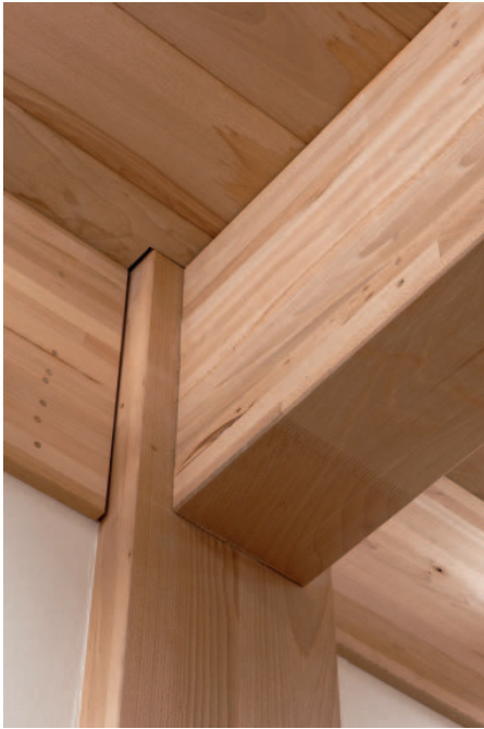
Extrem belastbarer Hochleistungsknoten mit Buchen-Konstruktionsholz im mehrgeschossigen Holzbau
