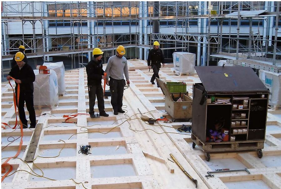
Die Decke aus Buchenelementen im «Woodstock»-Musterhaus trägt so gut, wie wenn sie aus Beton wäre. ZVG
